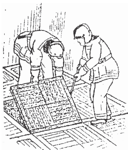
Рис. 10.7. Вскрытие щитового паркета
