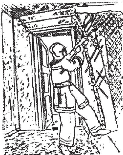
Рис. 10.9. Отрывание дранки от перегородки
